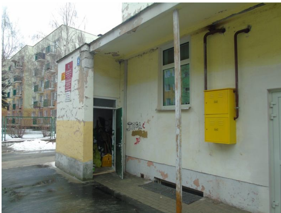
Fot. 8. Ogólny widok elewacji budynku.
