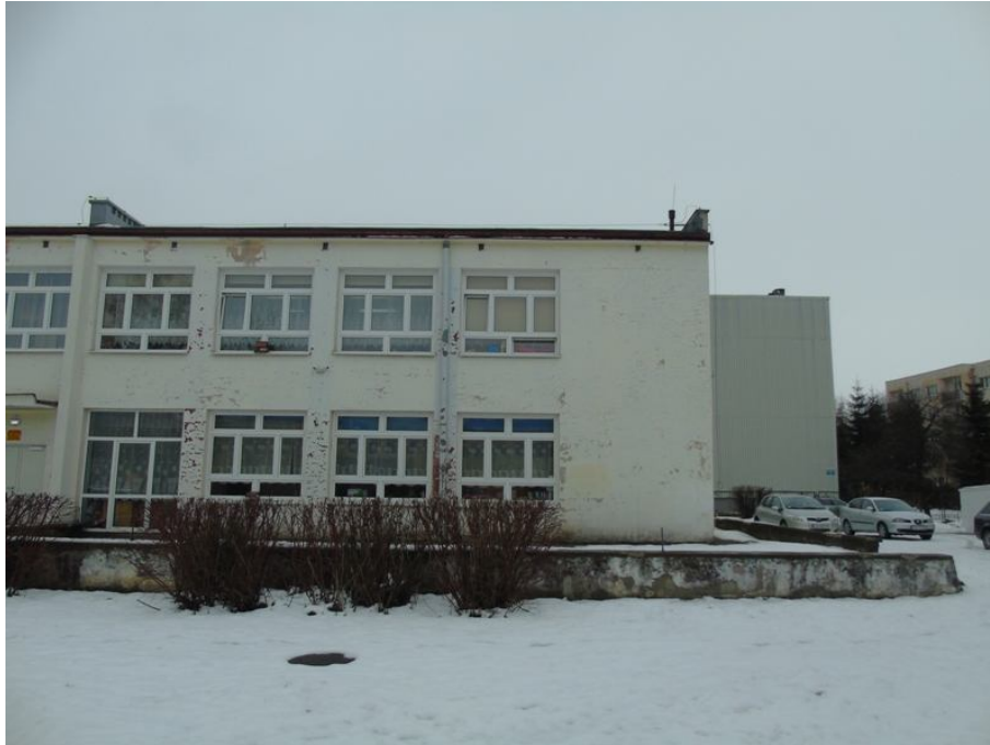
Fot. 4. Ogólny widok elewacji budynku.
