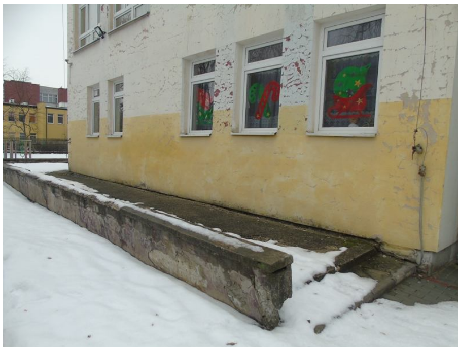
Fot. 2. Ogólny widok elewacji budynku.
