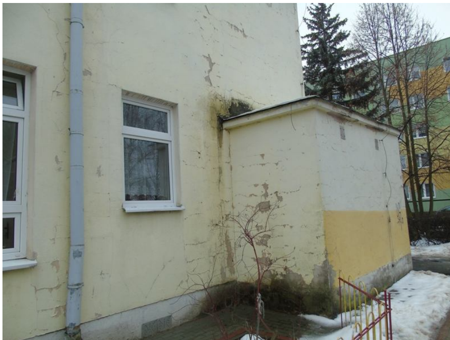
Fot. 7. Ogólny widok elewacji budynku.
