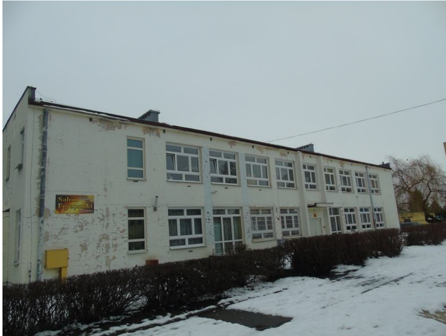
Fot. 10. Ogólny widok elewacji budynku.
