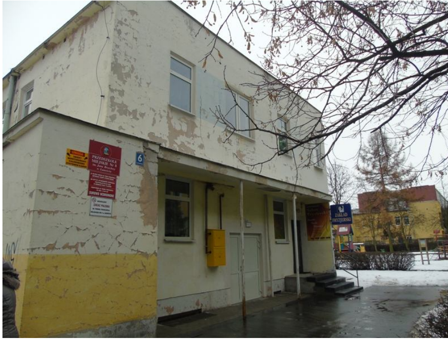
Fot. 6. Ogólny widok elewacji budynku.
