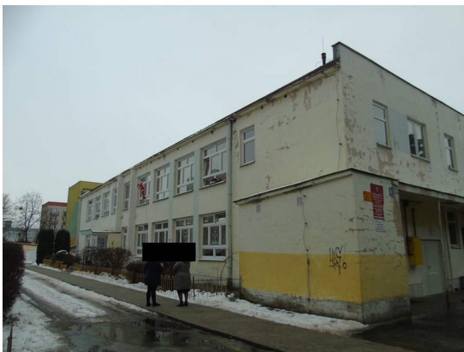
Fot. 9. Ogólny widok elewacji budynku.
