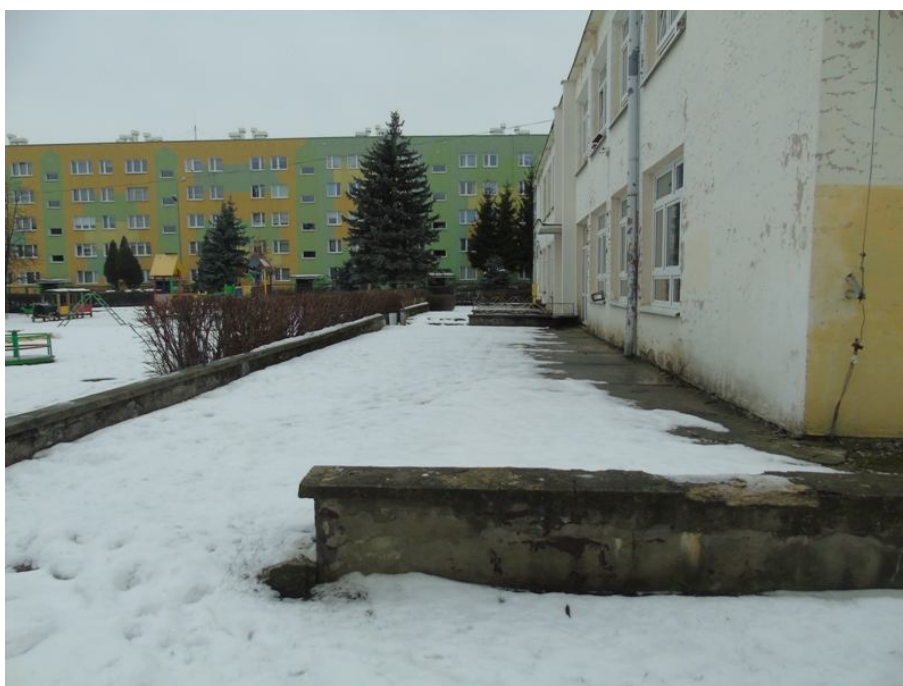
Fot. 3. Ogólny widok elewacji budynku.
