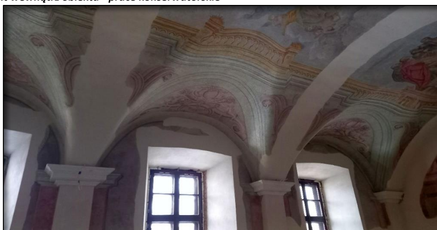
Zdjęcie 2 Remont wewnątrz obiektu - prace konserwatorskie
