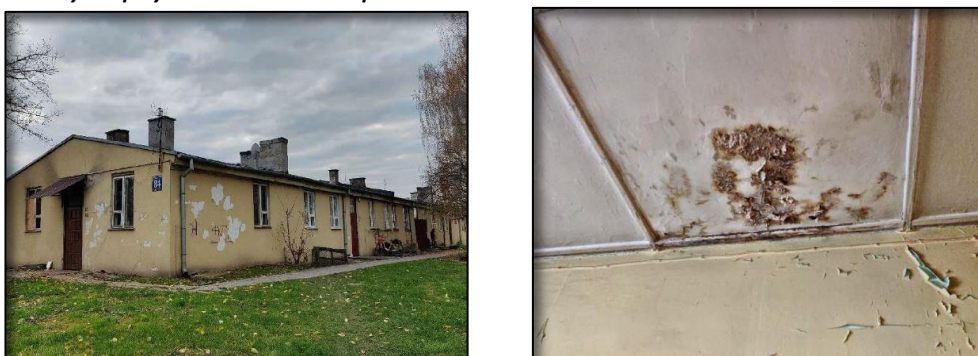
Zdjęcie 11 Budynek przy Peowiaków 82 i 84 przeznaczone do rozbiórki
