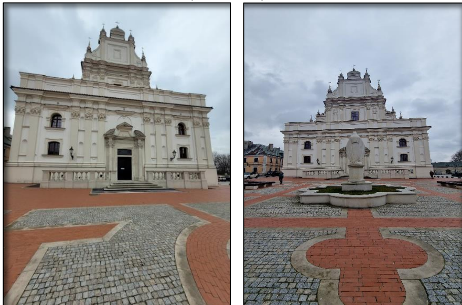
Zdjęcie 8 Elewacja zachodnia Kościoła oo. Franciszkanów po rewitalizacji
