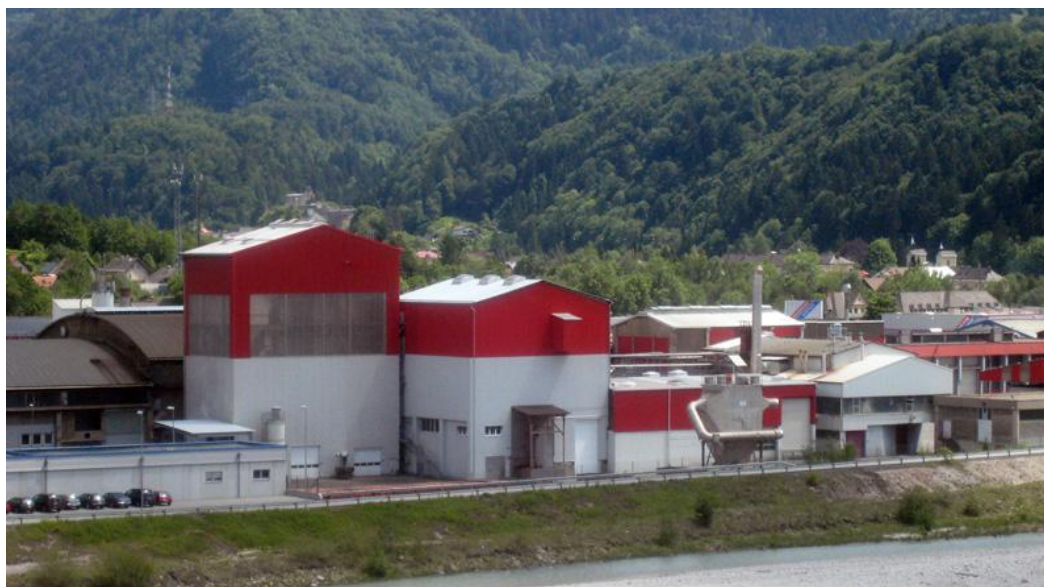
Rysunek 6: Instalacja Termicznego Przekształcania Odpadów w Arnoldstein (Austria)
