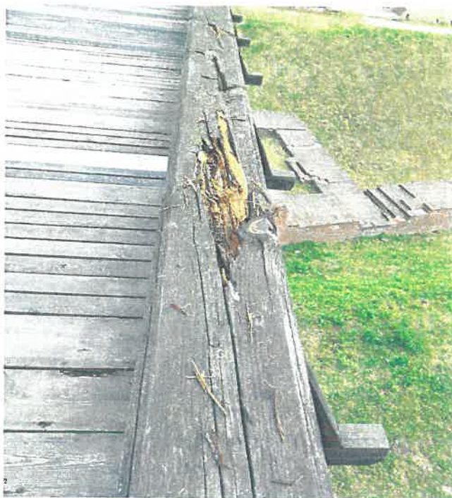
7. Ubytki i spękania w poręczy barierki mostu
