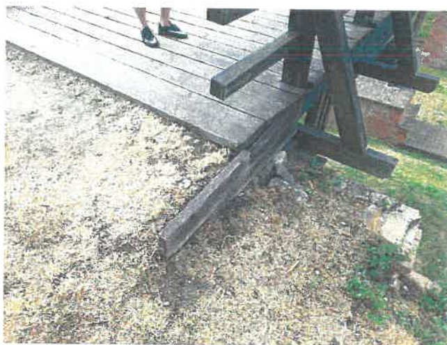
5. Zdegradowana deska ograniczająca
